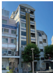
呉服町プラザビル
